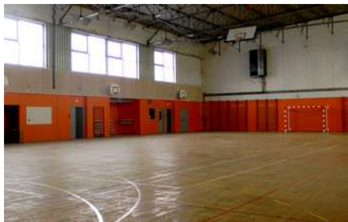
Poursuite des travaux prévue été 2015
